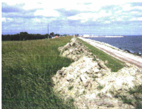
Afbeelding 2: Dijk ten oosten van de haven van Colijnsplaat.
