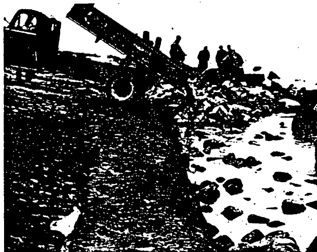
Fig. 34. Met lichte stortsteen wordt de aanwezige bestorting opgevuld en onder een gelijkmatig profiel gebracht. (zie ook fig. 33).
