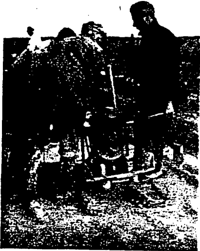
Fig. 18. Het verdichten van het beton met behulp van een kleine plaatvibratie-machine.
