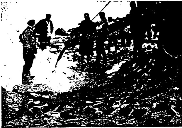
Fig. 35. Het ingieten met asfalt van de steenbestorting. Men lette op de sterke dampontwikkeling welke ontstaat als het hete asfalt met water in aanraking komt.
