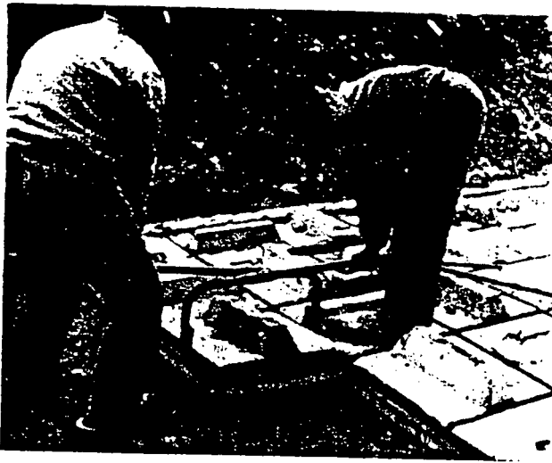
Fig. 29. Het op hun plaats leggen van de blokken met een speciaal hiervoor gemaakte tang.
