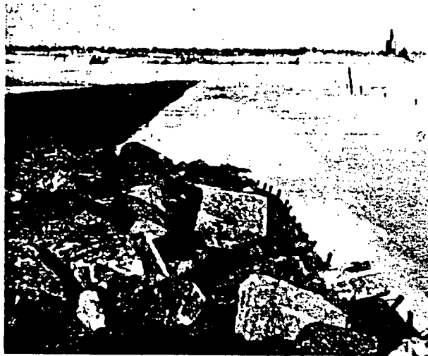
Fig. 24. Gezicht op het in de droge gemaakte gedeelte vanaf het punt der constructiescheiding. Op de voorgrond een gedeelte van het eerste zinkstuk met steenbestorting. Rechts op de achtergrond is boven de nieuwe dijk de top van de vuurtoren zichtbaar.
