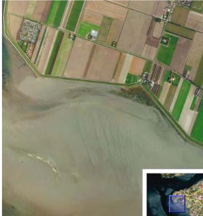
Figuur 2: Luchtfoto van het traject Nieuwe- Annex- Stavenissepolder "zuid" (bron: www.maps.google.nl )
