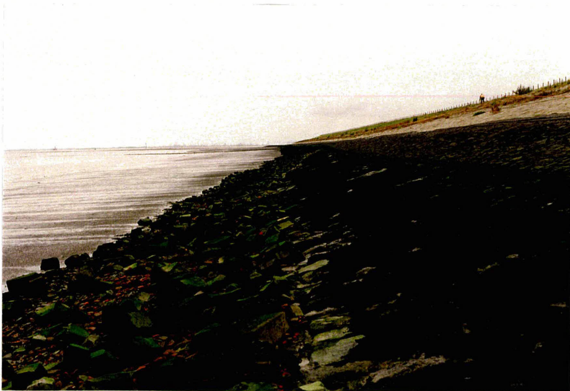
Foto 8 Overzicht van de locatie ter plaatse van dp 201,5 in oostelijke richting
