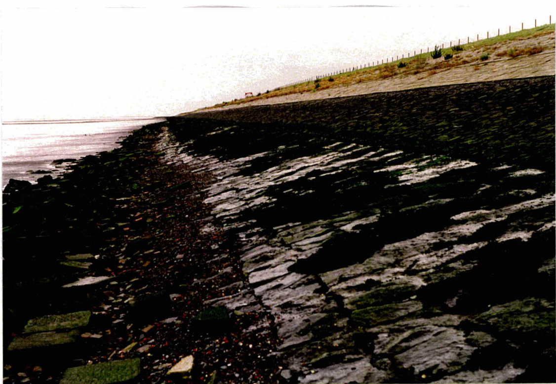
Foto 2 Overzicht van de bekledingen bij dp 203,5 in oostelijke richting
