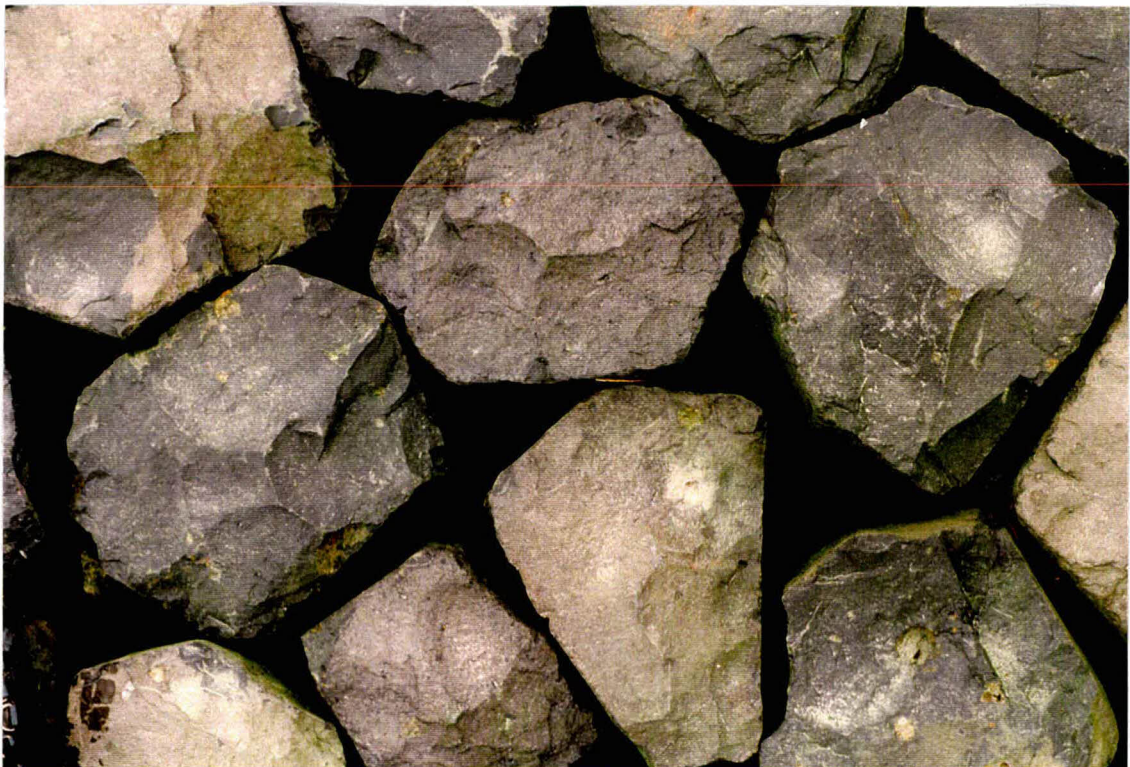
Foto 4 De basaltbekleding is niet dichtgeslibt. De basalt is ruim gezet.
