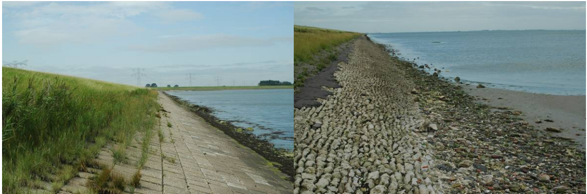
Foto 1.1: Dijktraject Karelpolder Nieuwlandepolder.
