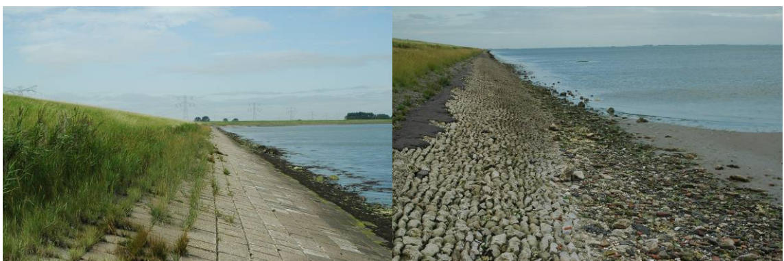
Foto 1.1: Dijktraject Karelpolder Nieuwlandepolder.
