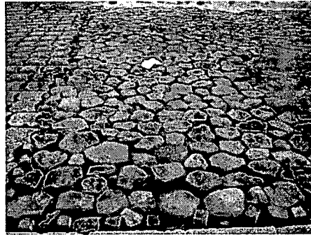
Foto 4: niet-ingegoten basalt (dijkpaal 222+65m)
