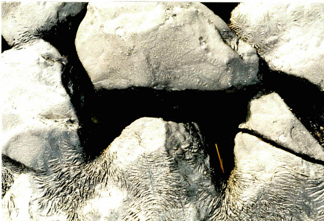
Foto 16 Hier en daar zitten grote gaten in de penetratie. Hier is een emmer water ingegoten dat binnen enkele seconden wegstroomde.
