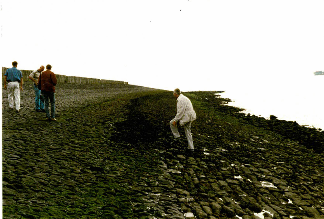
Foto 10 Naast de spuisluis, bij km 75 is aan de onderzijde doornikse steen aanwezig.
