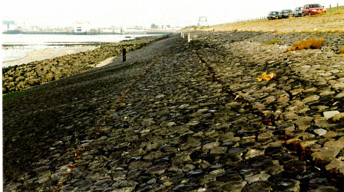
Foto 19 Overzicht van het einde van het dijkvak. De basalt is sterk wisselend van kwaliteit.
