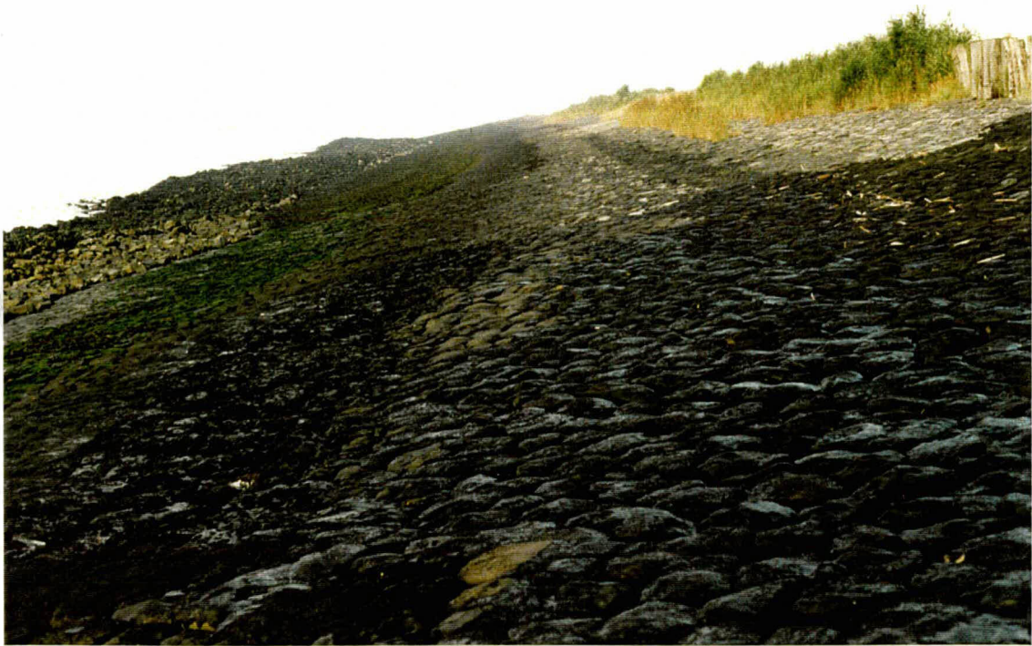
Foto 15 Overzicht van het einde van het gepenetreerde vak in westelijke richting. De penetratie is hier over vrijwel de gehele hoogte aanwezig.
