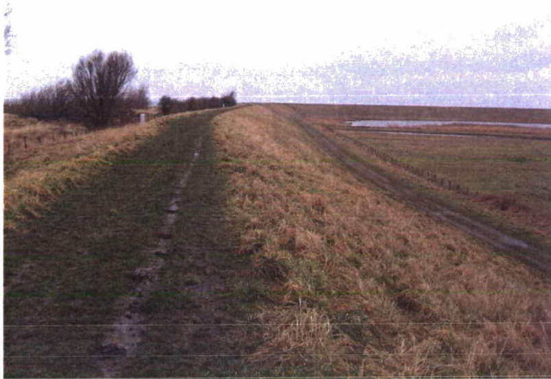
Foto 2.3 De kruin van de dijk tussen dp1900 en dp1905 wordt intensief gebruikt door recreanten (gezien in noord-oostelijke richting). Een berm aan de buitenzijde(links) ontbreekt vanwege het aanwezige duinterrein. In de toekomstige situatie is de kruin verhard met een onderhoudspad van asfaltbeton.
