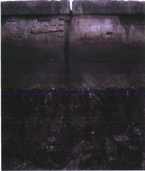
Foto 2: Aansluiting tussen 4 caissons en randbalk
