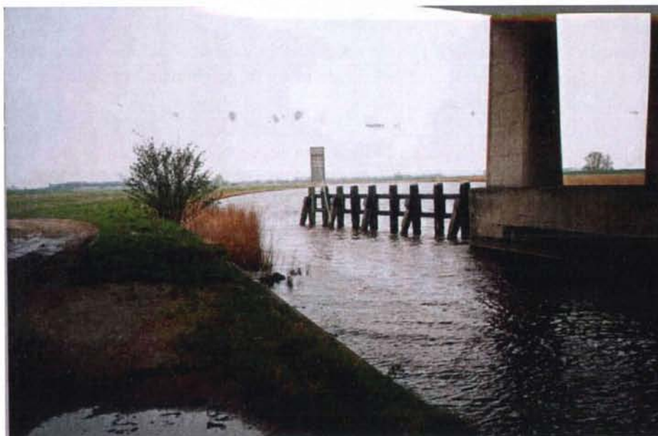
Foto 6 Locatie 4; Dintel, viaduct, vanaf de oostelijke oever gezien in zuidelijke richting (foto: TNO-MEP).
