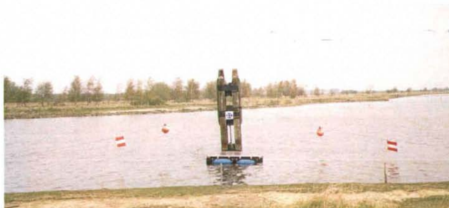
Foto 10 Het mosselfilter geïnstalleerd op de proeflocatie in de monding van de Steenbergse Vliet. De markering van de opstelling ter voorkoming van verstoring is duidelijk te zien.
