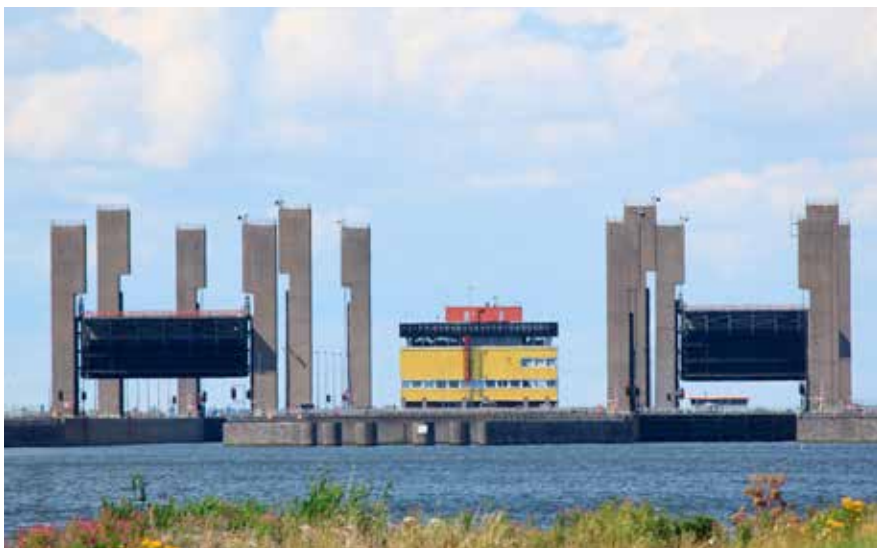
De Kreekraksluizen met middenin het bedieningsgebouw
