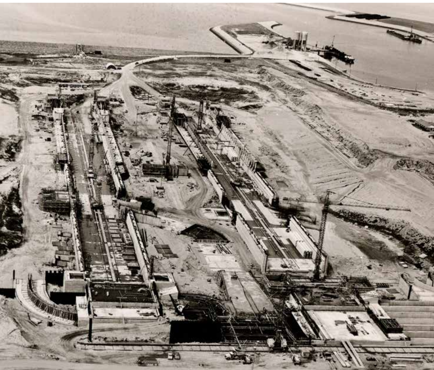
Het Kreekraksluizencomplex in aanbouw (1971)
