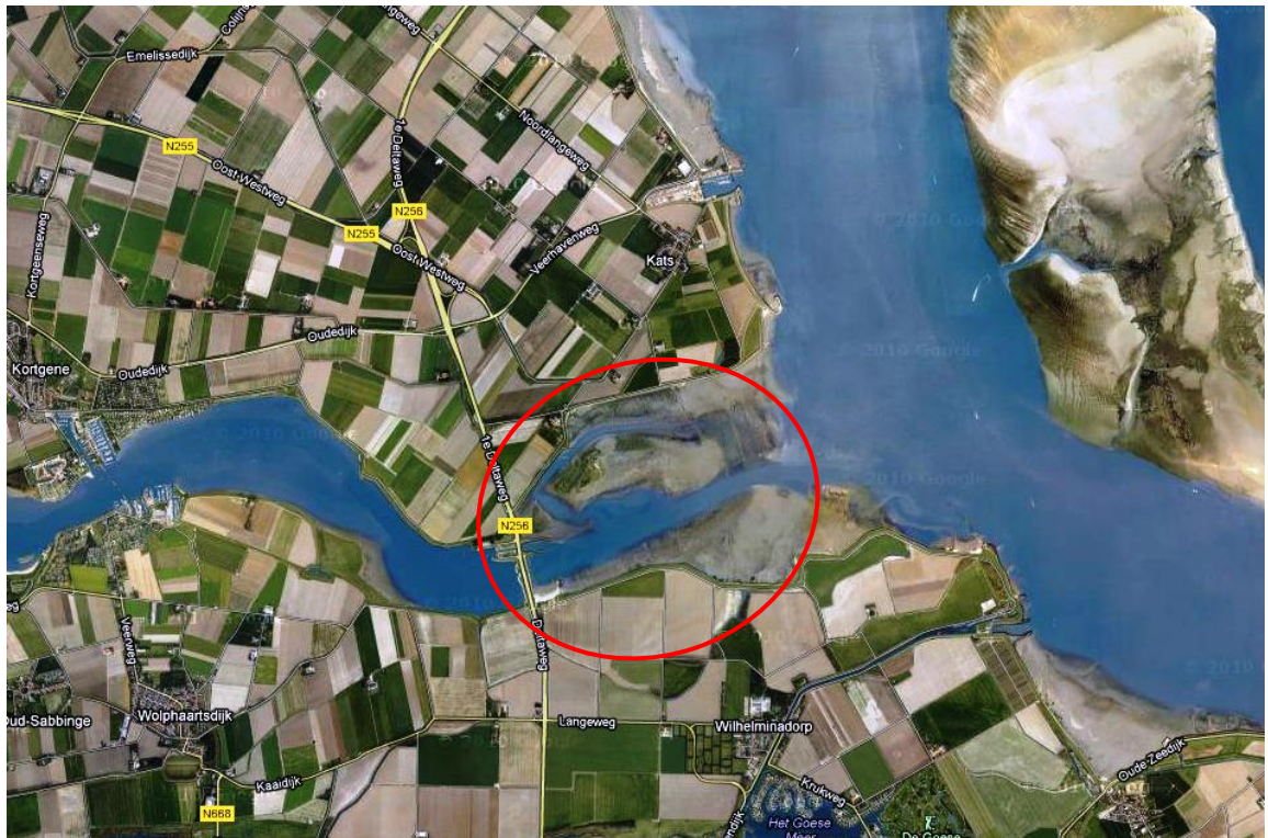
Figuur 1.2: Luchtfoto van het dijktraject Zandkreekdijk - Wilhelminapolder West (bron: google.maps.nl).
