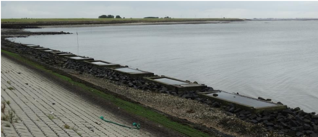
Foto 2: Sommige bakken zijn gedeeltelijk afgedekt met een betonplex plaat. In de betonbak op de voorgrond ligt de afstroomopening aan de landzijde.
