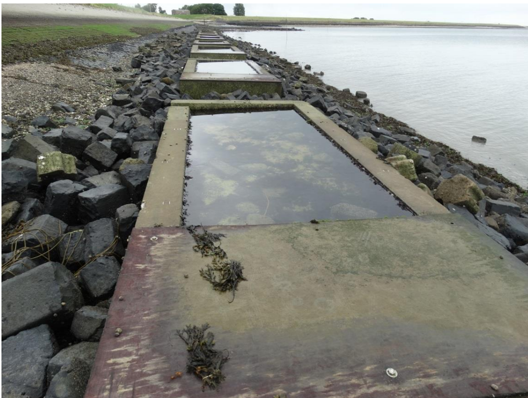
Foto 2: Sommige bakken zijn gedeeltelijk afgedekt met een betonplex plaat. In de betonbak op de voorgrond ligt de afstroomopening aan de landzijde.
