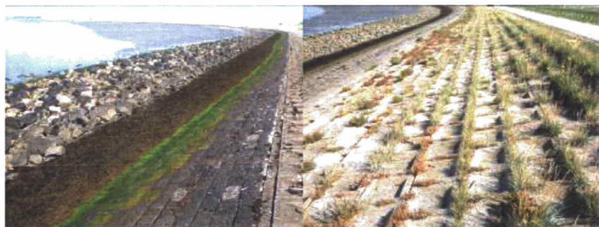
Foto 2.1. De kreukelberm en koperslakkblokken (ondertafel) en haringmanblokken (boventafel) op de Oesterdam Noord.
