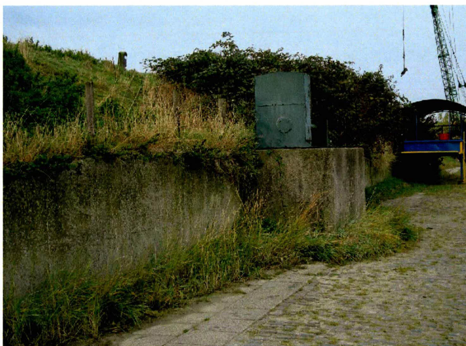
Figuur 1: Sluisje op betonnen scherm
