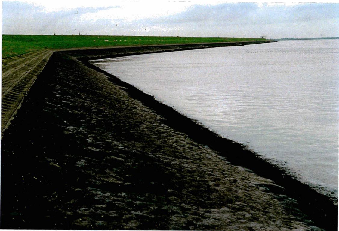
Foto 1 Overzicht van de locatie. Foto genomen in noordelijke richting bij km 36,5.
