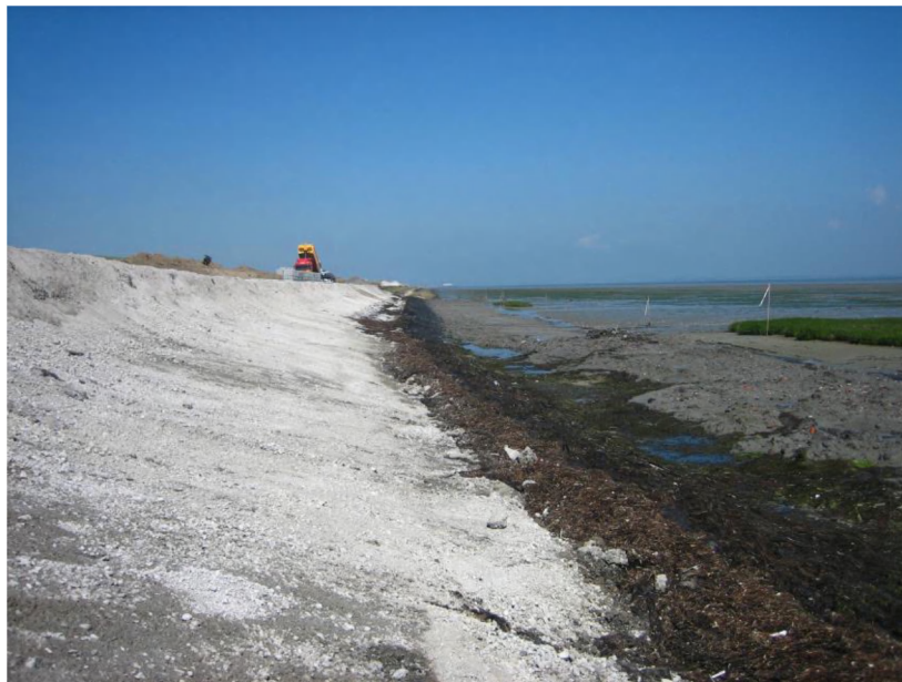
Figuur 6 Werkzaamheden in het kader van dijkverzwaring (Zuid-Beveland midden)
