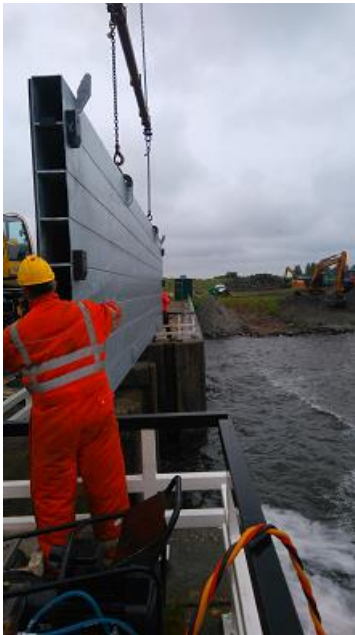
Plaatsen van de droogzetschotten
