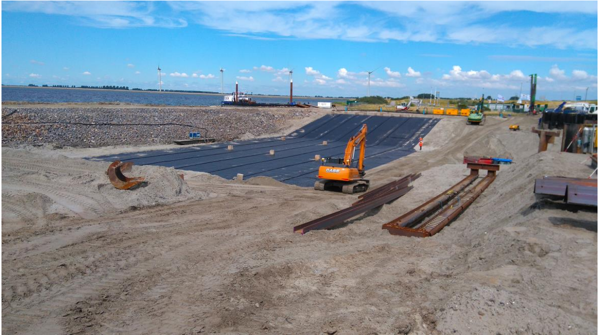
Bovenaanzicht van het aangebrachte geotextiel. Op het textiel wordt een filterconstructie aangebracht met daarop het stortsteen, zoals u kunt zien in de volgende foto.
