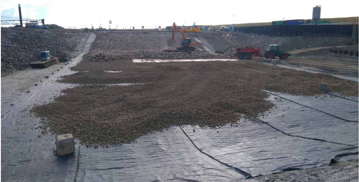
Op deze foto ziet u de opbouw van het stortebed in verschillende fasen. Op het geotextiel (voorground) wordt de filterlaag op het textiel aangebracht om het doek te beschermen (midden). Op deze filterlaag komt het zwaardere stortsteen te liggen (achtergrond).
