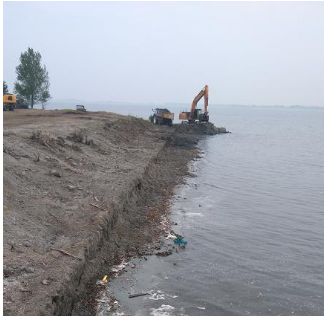
Verwijderen van bestorting en beschoeiing aan de Grevelingen
