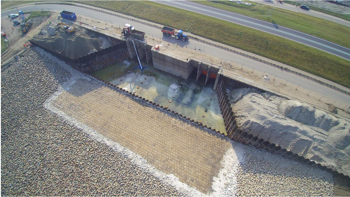
Op de foto ziet u de zes verschillende kokers, de nieuwe damwanden ter geleiding van het water en de diffuserwand voor de betonblokken, welke het water wat uit de kokers stroom sterk afremt.
