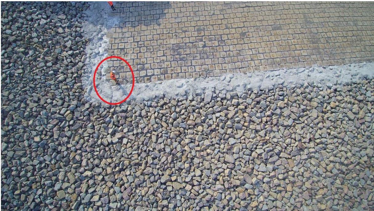
Deze foto geeft u een indruk van het daadwerkelijke formaat van de betonnen vloer net na de diffuserwand. Zoals u ziet zijn de betonblokken welke zijn hergebruikt van behoorlijke omvang. Desondanks is de vloer en de achterliggende bestorting enorm strak aangelegd. Een sterk staaltje vakmanschap!
