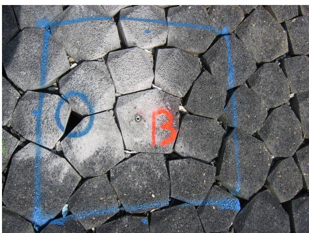
Figuur 45: Voorbeeld in Sluis van een vak waarin de inwassing is beoordeeld. Geheel leeggespoelde gaten zijn blauw omcirkeld (hier is slechts één cirkel zichtbaar)
