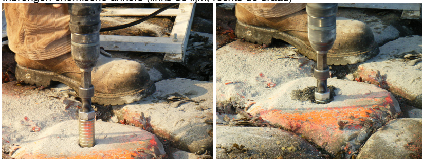
Vermengen lijm en inbrengen van draad met de boormachine
