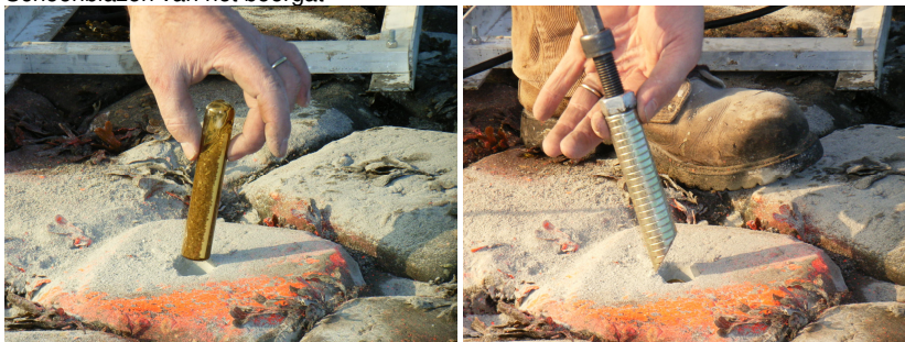
Inbrengen chemische ankers (links de lijm, rechts de draad)
