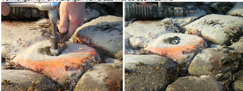
Figuur 25: Foto's werkwijze aanbrengen chemische ankers
