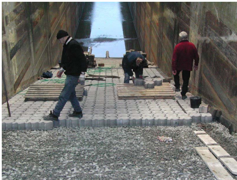
Fig. 3.11 Inbouw 15 cm dikke Hydroblocks op 6 à 7 cm dik filter
