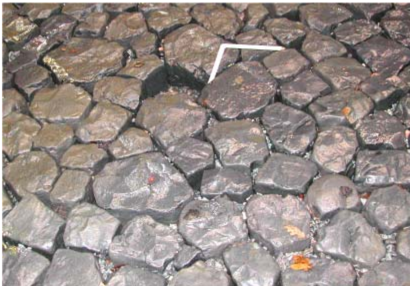
Figuur 3.5 Schade na proef P4618 (serie 3) (z = 3,50 m)
