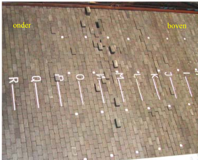
Fig. 3.7 Schade tijdens proef P4122 na totaal 3,62 uur golven (zie ook figuur C6) (serie 1)
