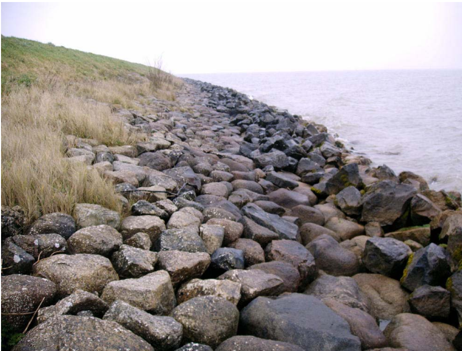
Figuur 4.2. Talud van Noorse steen met een breuksteenberm net boven NAP
