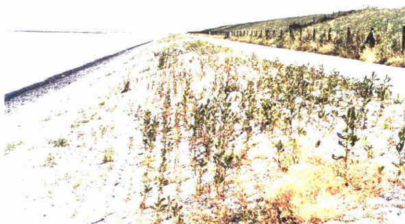
Foto 8: Overzicht dijktraject langs de Hoofdplaatpolder
