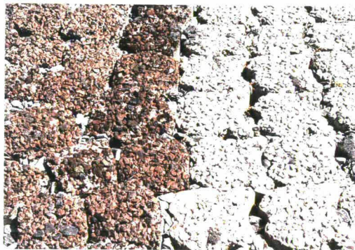
Foto 2: Betonzuilen met ecotoplaag (links Basalton, rechts Hydroblok)
