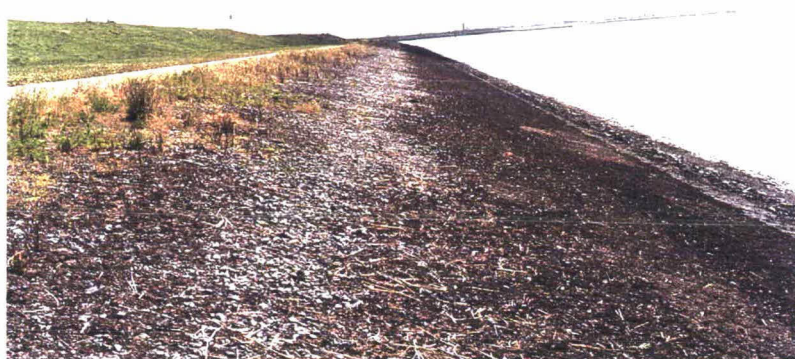
Foto 5: Overzicht dijk langs Borsselepolder (betonzuilen met ecotoplaag, Basalton)
