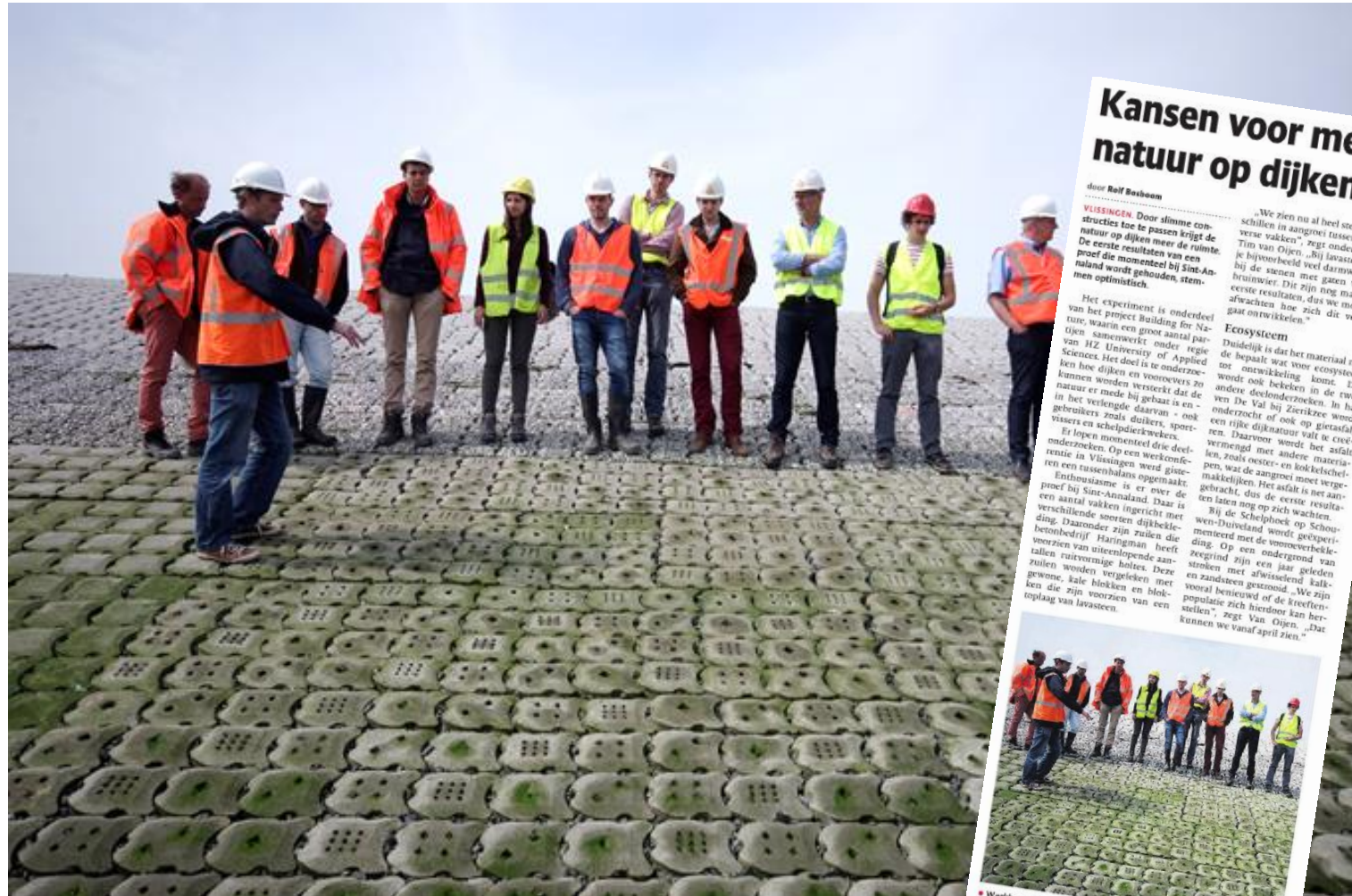
• Werkbezoek aan het proefdijkvak bij Sint-Annapolder. De betonzuilen zijn voorzien van gaten. Foto: Tjerk van Erven/HZ Delta Academy
