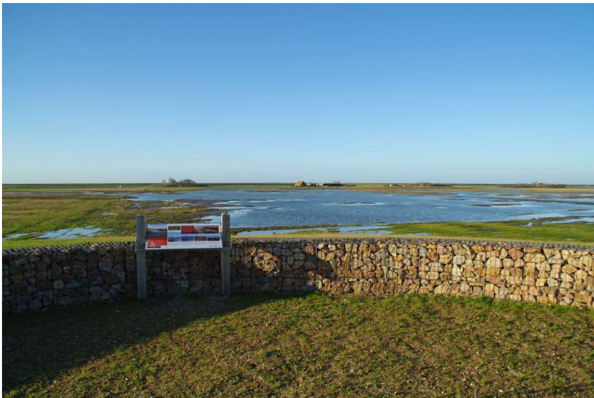
Met de aanleg van het Gasthuisbevang werd het laatste grote deel van de natuurbouw van 'plan Tureluur' op de zuidkust van Schouwen uitgevoerd (foto: Rob Strucker).
