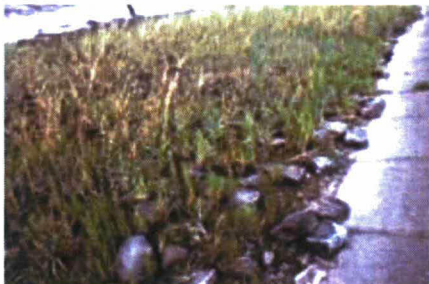
Werkstrook voor en na de dijkverbetering
