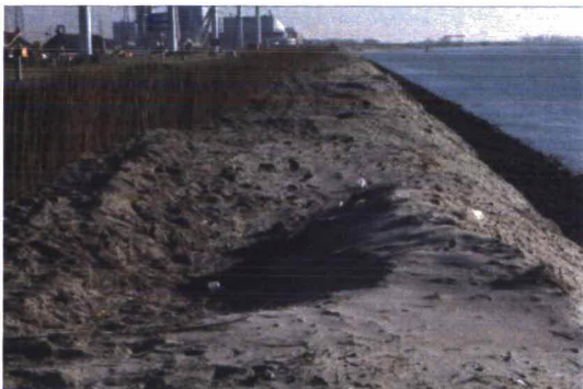
Rijshoutscherm Sloedam – Kaloot / uitspoeling dijklichaam Van Citters
