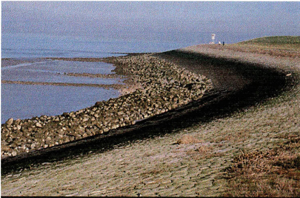
Zeedijk Kleine Huissenspolder, Zeeuwsch Vlaanderen, 15 februari 2001. Nieuw beklede zeedijk (uitgevoerd 1997): ondanks geringe hoeveelheid steenslag toch gebruikt als broedplaats door Strandplevier. Er is een brede overlaging aangebracht, die een barrière vormt voor jonge plevieren tussen dijk en slik (foto Peter L. Meininger)
