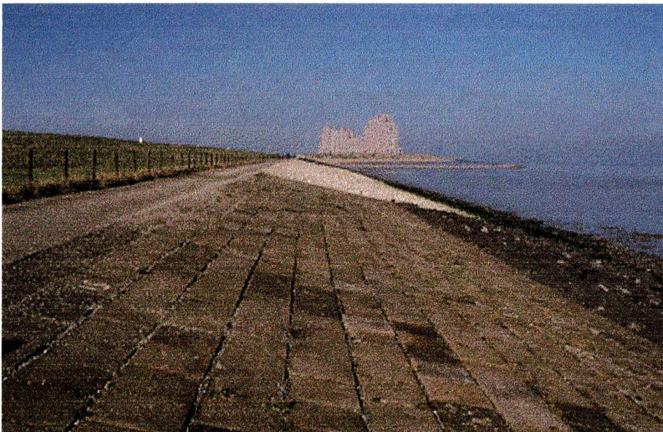
Zeedijk Elisabethpolder, Zeeuwsch Vlaanderen, 15 februari 2001. Nieuw beklede zeedijk (uitgevoerd 1999): kale, vlakke dijk (vooraan) of juist zeer reliëfrijk met beton overgoten stenen: ongeschikt voor broedende plevieren. Ook deze fietser liet zich niet tegenhouden. (foto Peter L. Meininger)
