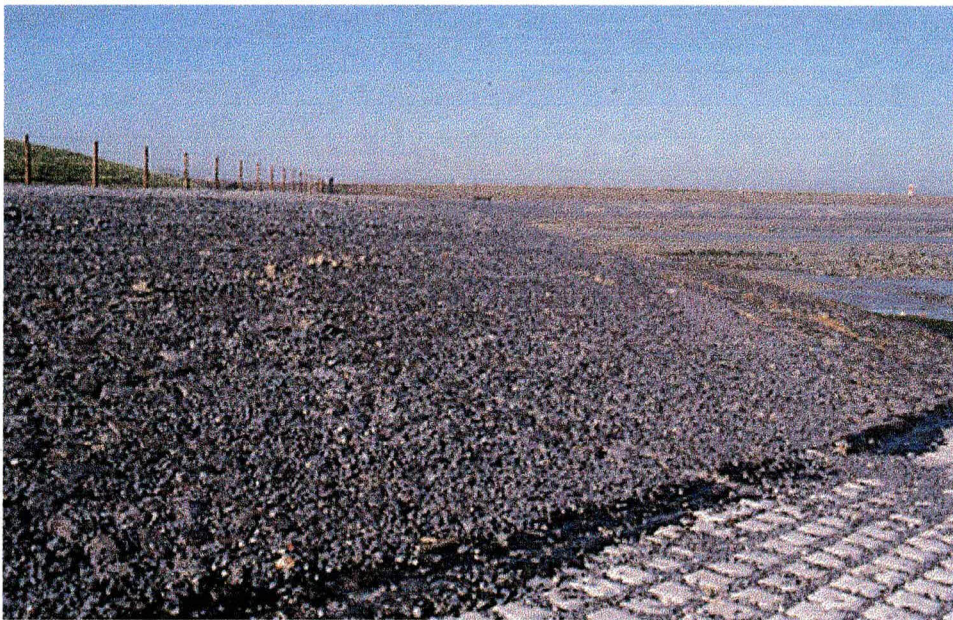
Zeedijk Thomaespolder, Zeeuwsch Vlaanderen, 15 februari 2001. Nieuw beklede zeedijk (uitgevoerd 2000): veel steenslag, geen begroeiing, grenzend aan slik: potentiële broedplaats voor plevieren! (foto Peter L. Meininger)
