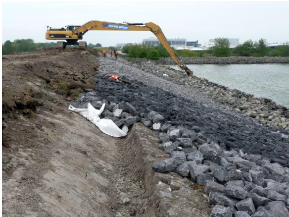
Wieringermeerdijk tijdens aanleg nieuwe bekleding
