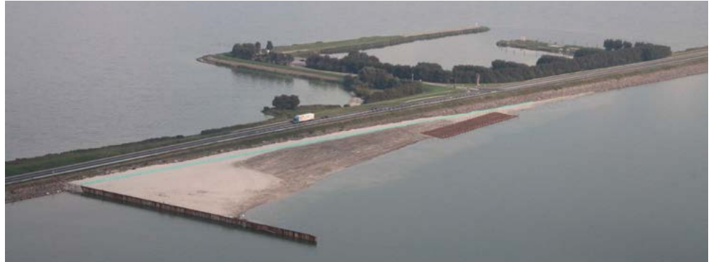
Proefsectie in september 2014, vlak na de aanleg.
