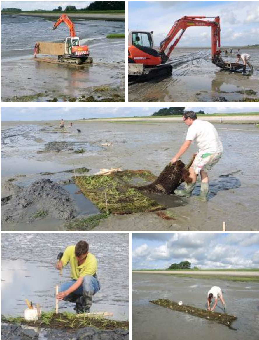
Figuur 9. Plaatsing van de matten. Linksboven: aanleg van metalen beplating op zachte slik bij Viane om de experiment locatie bereikbaar te maken. Rechtsboven/onder: plaatsing van de matten op het slik.
