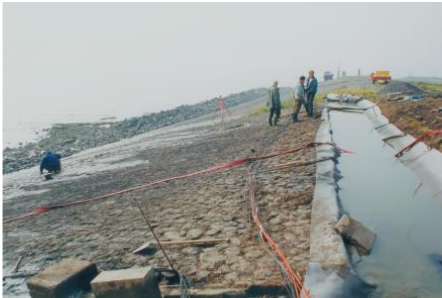
Figuur 2.2, inpompproef bij Kruiningen
