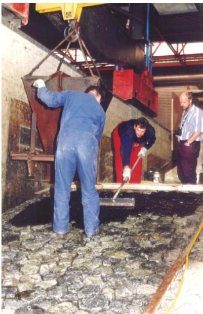
Figuren 2.1, overgieten van basalt in Deltagoot (links) en blaas van de gietasfalt na langdurige golfaanval (rechts)
