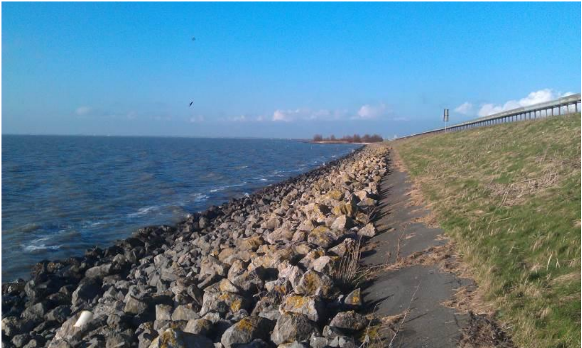
Figuur 3-5 Talud van de Houtribdijk aan de Markermeerzijde ten zuiden van Trintelhaven (januari 2014)
