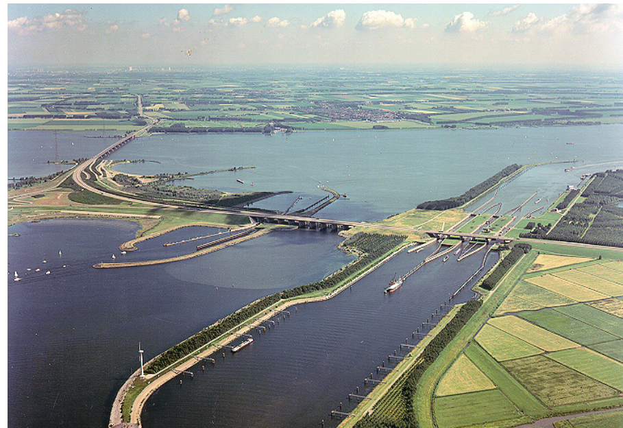
Afb. 3 Locatie van de maatregel: schutkolken beroepsvaart en jachtensluis Volkeraksluizen, Willemstad
