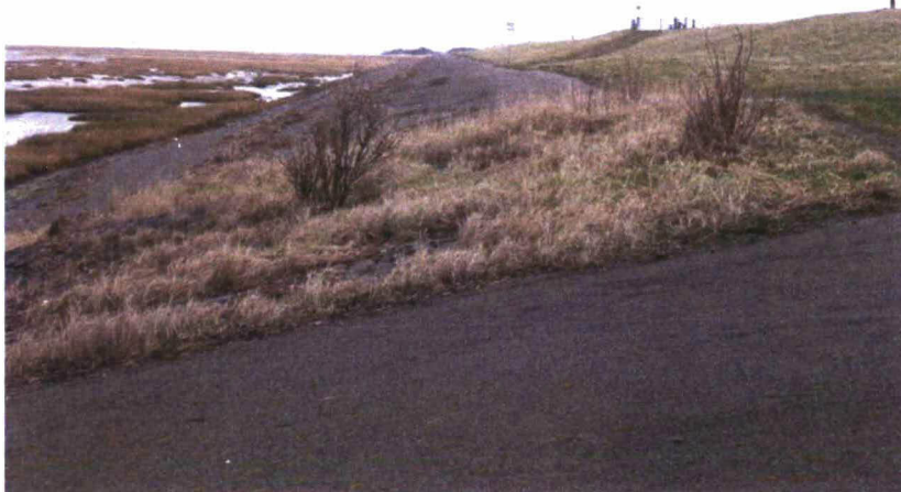
Figuur 2.2 Ter hoogte van de voormalige uitwateringssluis (dp309) zijn basaltzuilen in de boventafel aanwezig, in plaats van het asfaltbeton of grindasfaltbeton in rest van de boventafel. Tussen de basaltzuilen is duidelijk meer begroeiing aanwezig.
