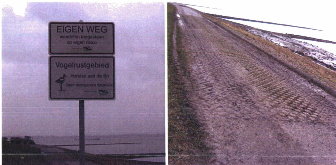
Figuur 1.3 Het buitendijks onderhoudspad is ter hoogte van dp298 afgesloten voor fietsers. De rechterfoto laat de 'barrière' zien waarmee het onderhoudspad in de huidige situatie onaantrekkelijk gemaakt is voor fietsers (geribbelde stenen over een korte lengte).
