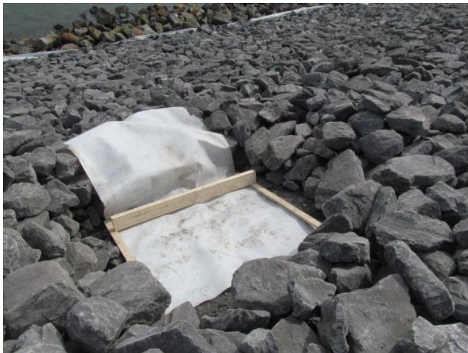
Figuur 4: Aanleg kalibratievakken
