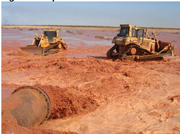
afbeelding 4.7. Verspreiden van zand door middel van bulldozers
