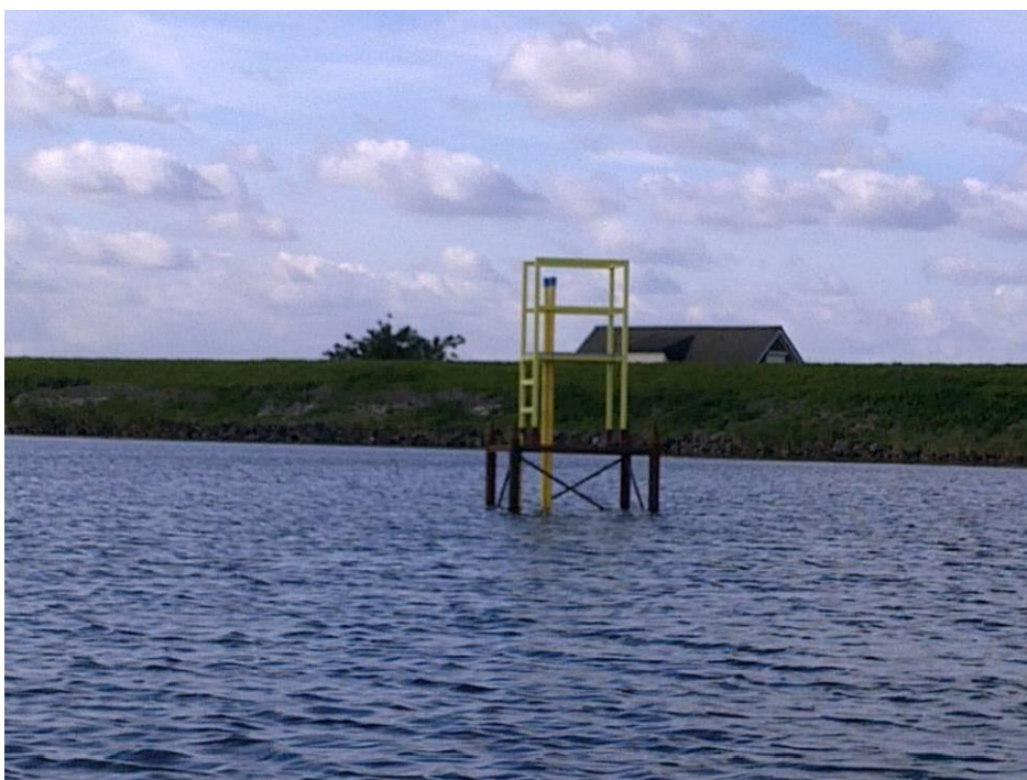
Figuur 6.2 Werkplatform met peilbuizen in het Markermeer
