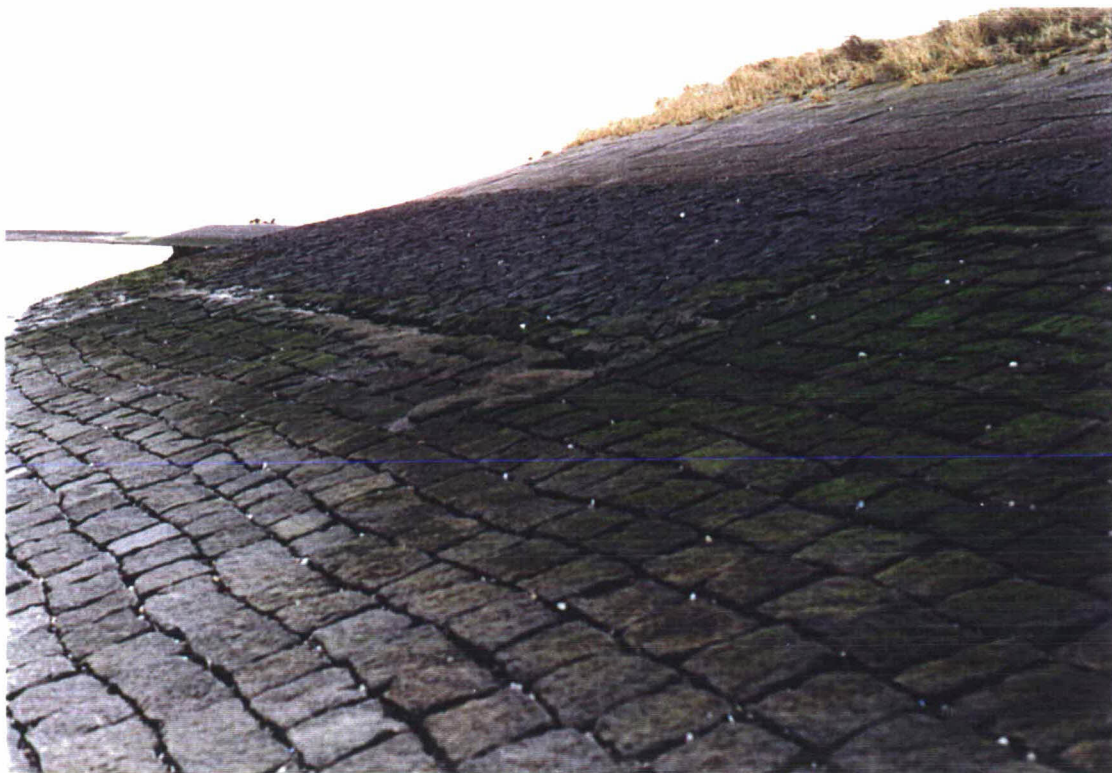
Foto 5: De hoogte waarover de granietblokken aanwezig zijn varieert. (foto bij dp 260+30 m in oostelijke richting)
