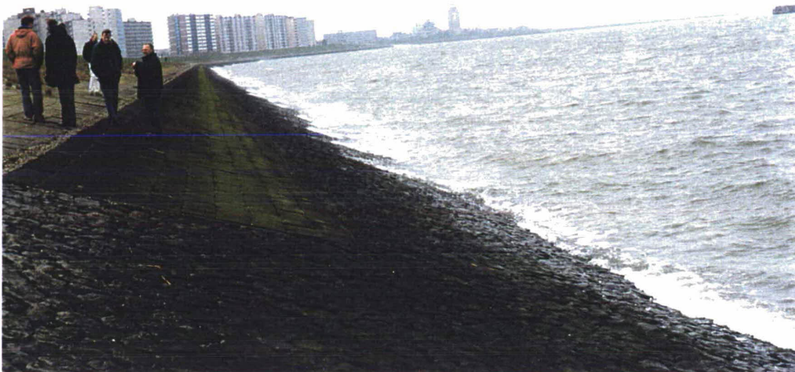
Foto 1 Overzicht van het oostelijk deel van de locatie. Genomen vanaf het begin van het vak, net om de bocht bij uitwateringssluis Othene, in westelijke richting
