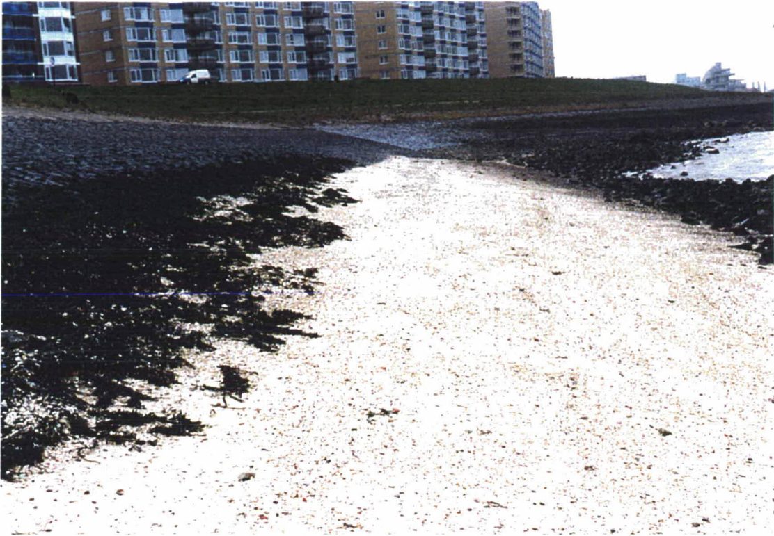
Foto 7 Bij dp 94 is de bekleding van koperslabblokken verborgen onder een schelpstrand.
