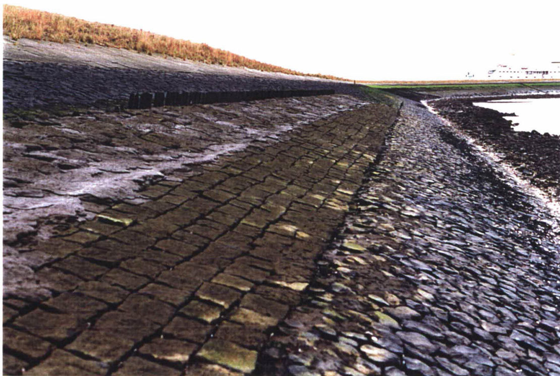
Foto 6 Aan het eind van het vak is maar een smalle strook graniet aanwezig. Foto genomen in westelijke richting. Boven de graniet ligt een strook gepenetreerde Doornikse steen. Achter de strekdam ligt de veerhaven.
