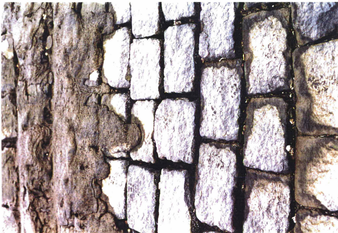
Foto 2 Graniet met daarboven overgoten Doornikse steen
