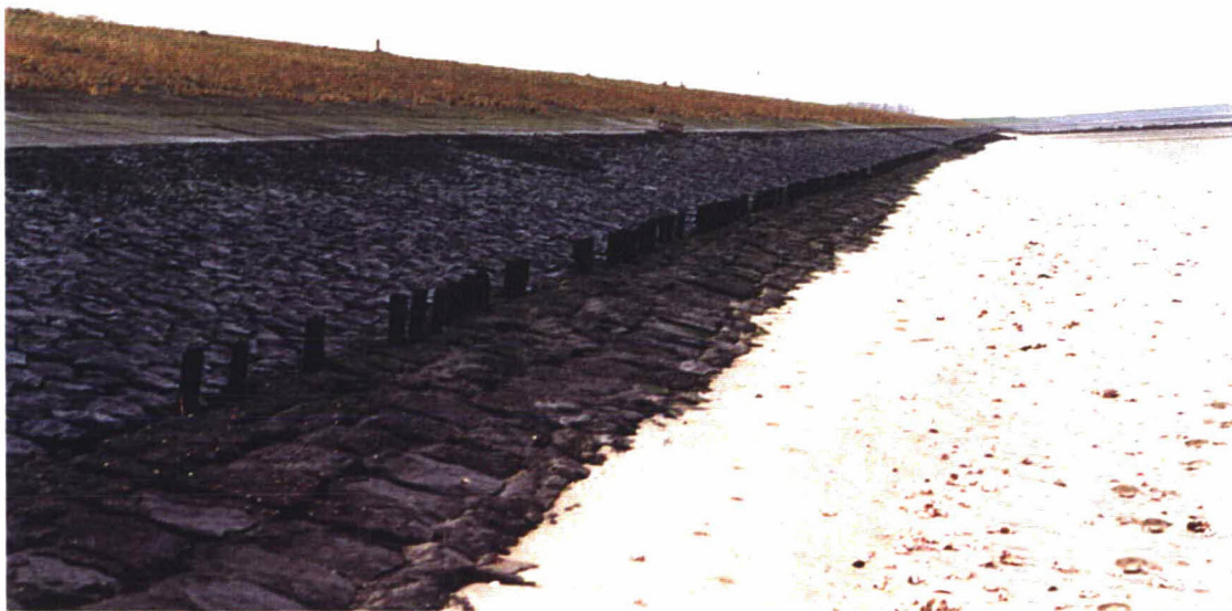
Foto 10 Overzicht van de locatie ten westen van de veerhaven. Foto genomen bij dp 269 in westelijke richting. Getoetst wordt de smalle strook Doornikse steen onderaan het talud.
