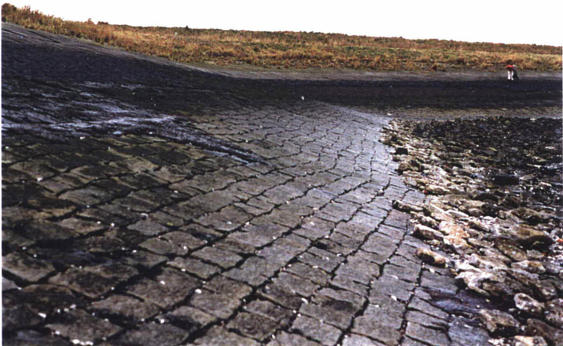
Foto 4 Overzicht van het westelijk deel van de oostelijke locatie. Foto genomen ter plaatse van dp 260 in westelijke richting.
