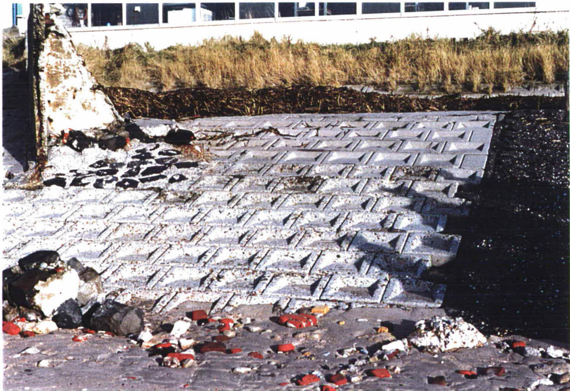
Foto 8 Aan de westelijke begrenzing van het bekledingsvak (het muurtje) grenst nog een klein stuk dat eventueel meegenomen zou kunnen worden in de renovatie van de Haringmanblokken
