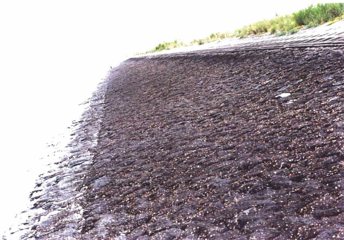
Foto 20 Overzichtsfoto van vak 39801, gepenetreerde basalt. De foto is in zuidelijke richting genomen vanaf het begin van het vak. Op de ondertafel liggen Doornikse blokken.
