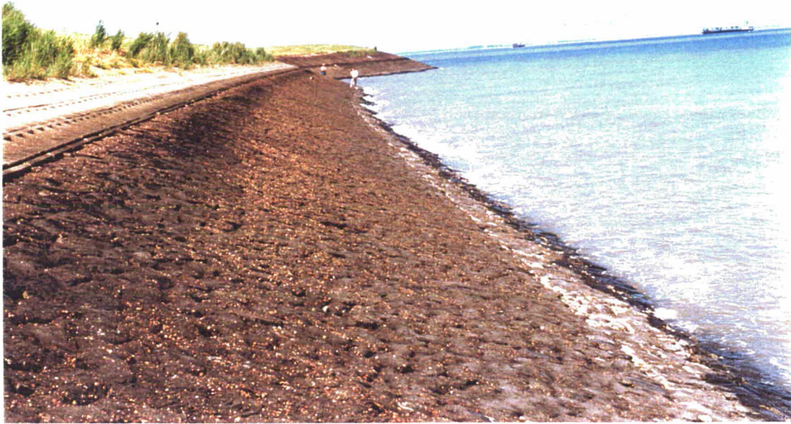
Foto 21 Zicht in noordelijke richting, ongeveer halverwege het bekledingsvak
