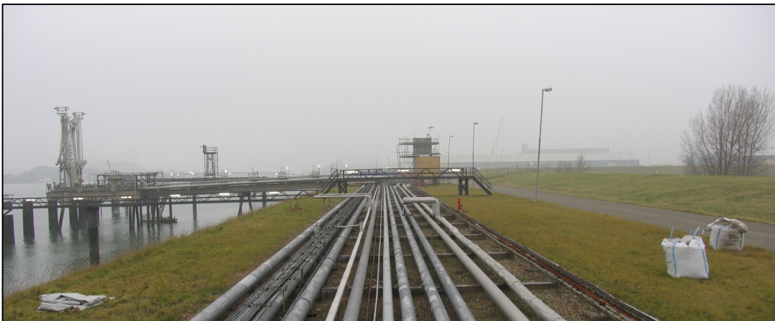
Figuur 1.3. Foto bestaande situatie met leidingenstraat, berm en hoogwaterkering.
