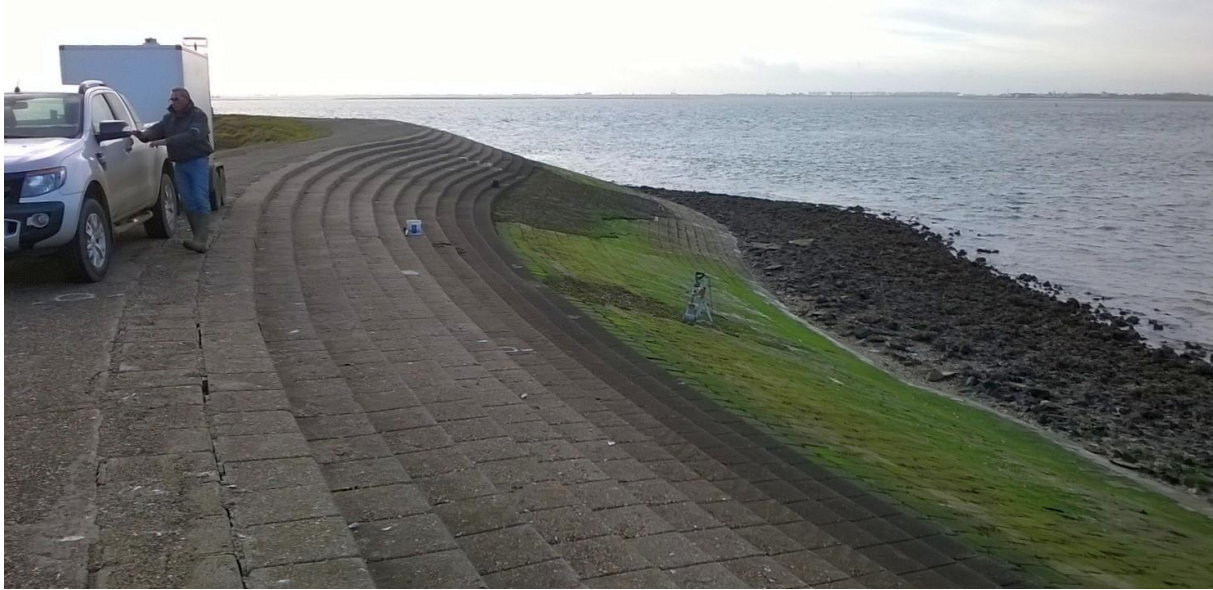
Figuur 3 – Boringen ter ondersteuning van de MIRA waarnemingen
