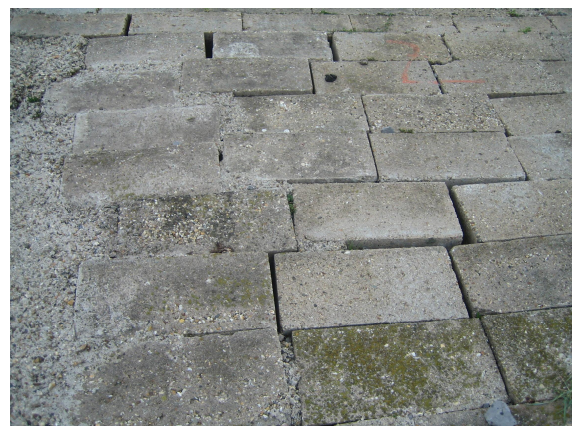
Figuur 6-2: Slecht geplaatste zuilen (links) en blokken (rechts). Is dit binnen de toleranties?
