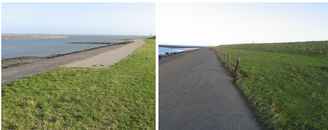
Figuur I-5: Monolieten bekleding asfalt
