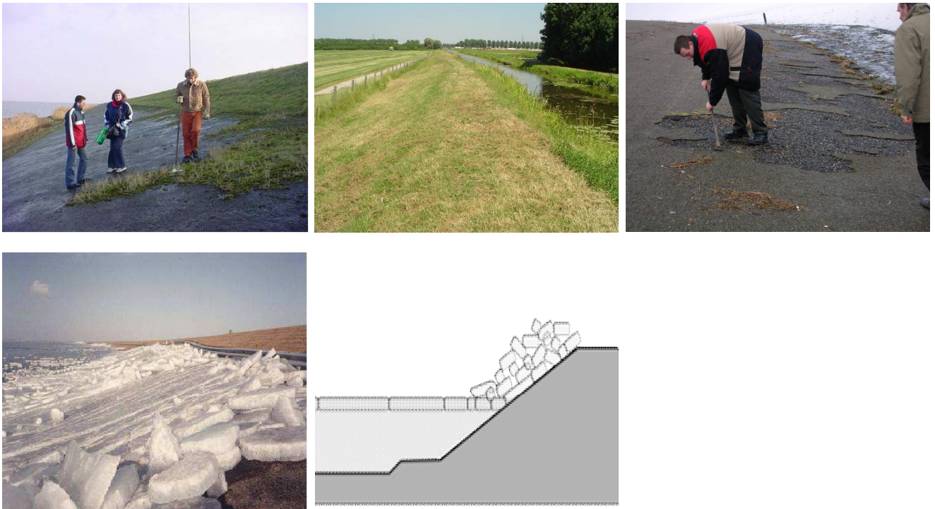
Figuur 3-11: Biologische aantasting, klimatologische aantasting, stripping (boven, vlnr) ijsbelasting, schematisch weergegeven ijsbelasting (onder, vlnr)
