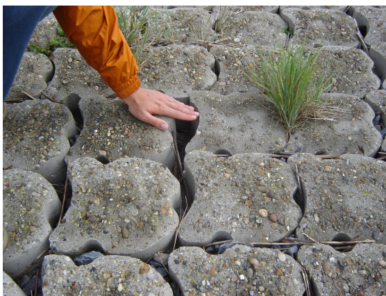
Figuur 6-2: Slecht geplaatste zuilen (links) en blokken (rechts). Is dit binnen de toleranties?
