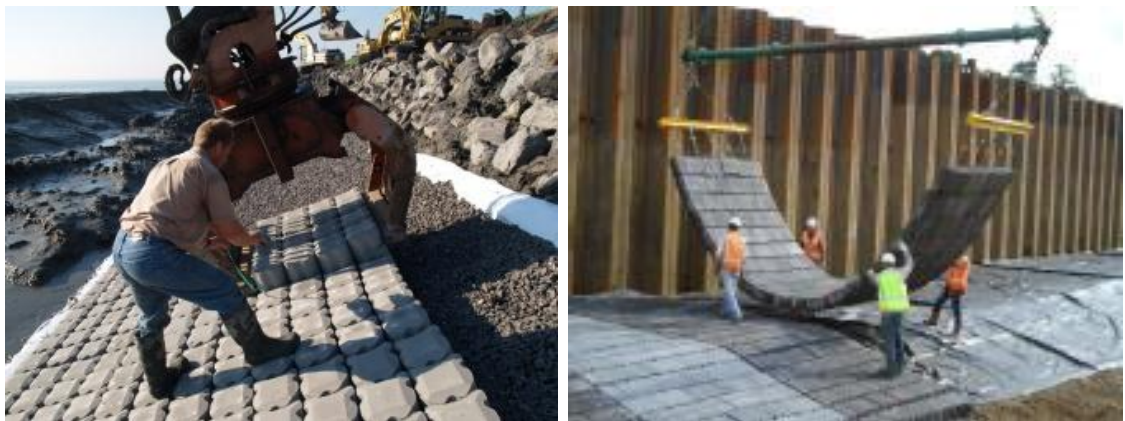
Figuur I-3: Plaatsing gezette bekleding (links) en plaatsing blokkenmat (rechts)
