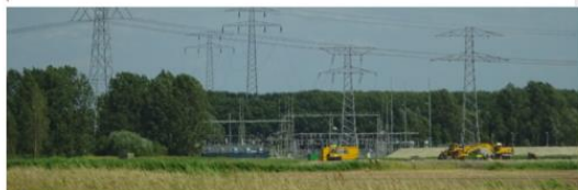
Figuur 9: 380 kV en 150 kV hoogspanningslijnen en hoofddeelstations in de bestaande en toekomstige (Anon. 2014)]
