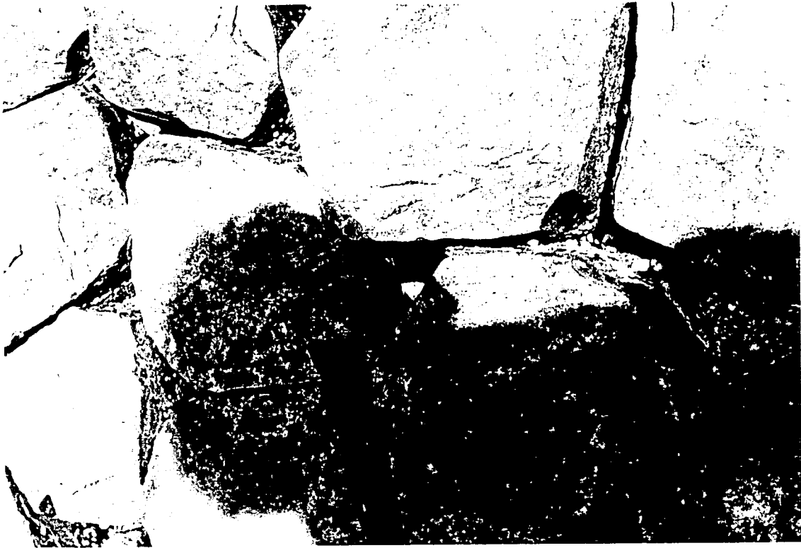
Foto 3 Oostelijke locatie: holte onder het blok
