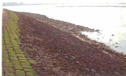
krukelberm ter hoogte van deelgebied 4/5
