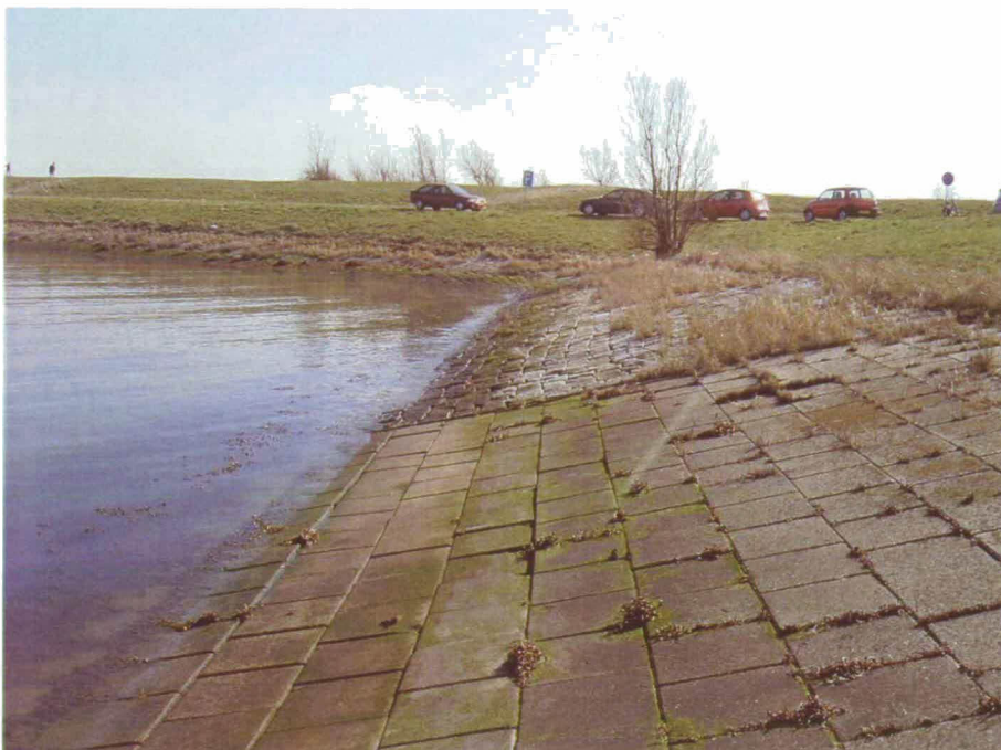
Figuur 7 Overgang van vlakke blokken naar Doornikse steen tussen deelgebied 6 en 7.
