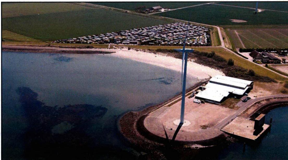
Afbeelding 3: Huidige situatie van de dijk tussen dp1934 en dp1942, waarbij het onderhoudspad niet is opengesteld. Ook goed zichtbaar is het strand met daarachter duin.
