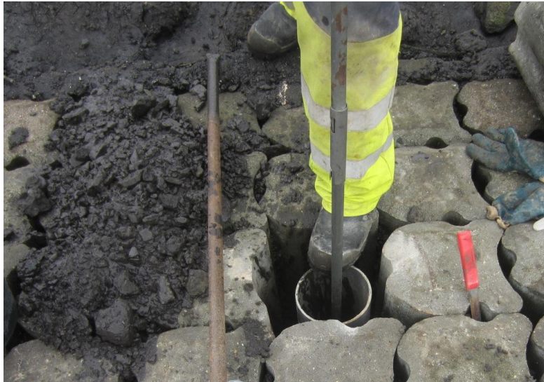
Figuur 3.8 Boren in onsamenhangend materiaal door gebruik te maken van een mantelbuis (casing)
