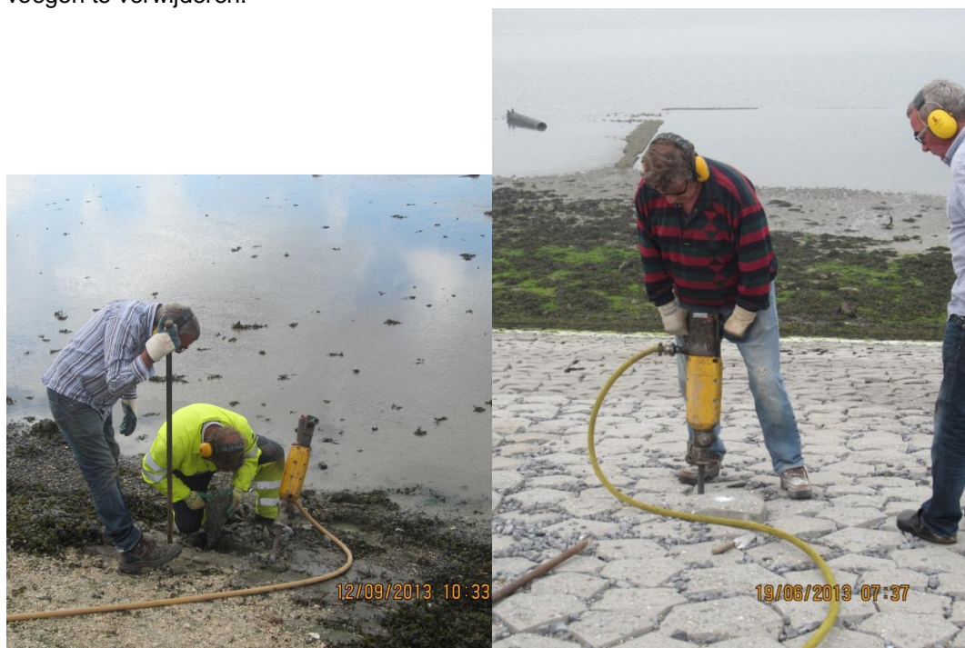
Figuur 3.5 Links: verwijderen deel van kapot gebroken Haringmanblok; Rechts: Bewerken van basaltzuil met een breekhamer in een poging om de zuil uit de zetting te krijgen
