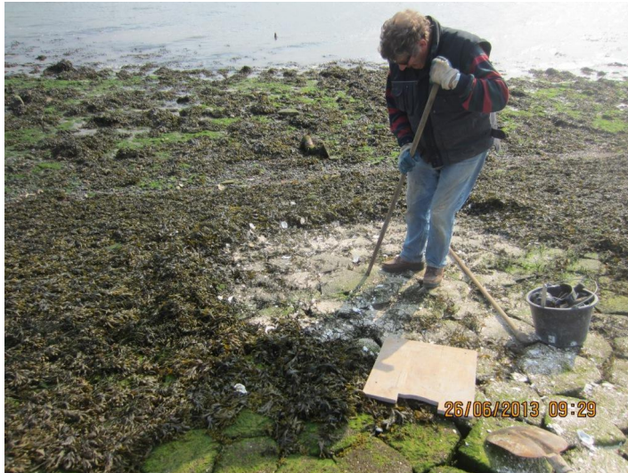
Figuur 3.3 Werkvlak is ontdaan van begroeiing met wieren (dijkpaal 1387 van "Polder De breede watering bewesten Yerseke")
