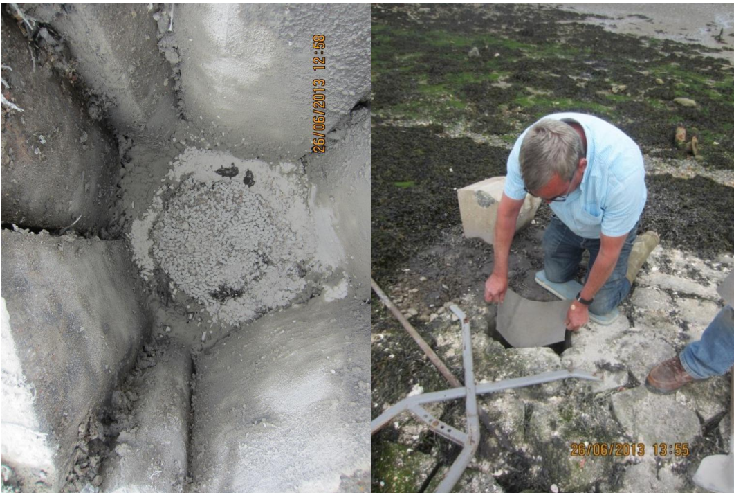
Figuur 3.12 Links: boorgat opgevuld met mengsel van klei, fijn grind en cement. Rechts: een nieuw stuk geotextiel wordt aangebracht over het originele, inmiddels weer dichte geklapte geotextiel
