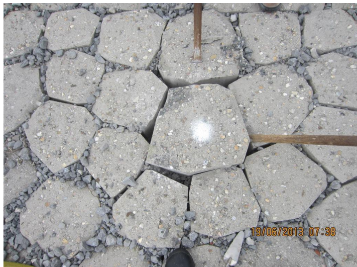
Figuur 3.2 Het grootste element uit het standaard pakket Basalton wordt uit de zetting genomen om een voldoende groot gat te krijgen om de onderlaag te onderzoeken
