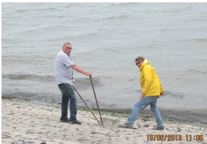
Figuur 3.4 Het element wordt uit de zetting gewrikt met stootijzers
