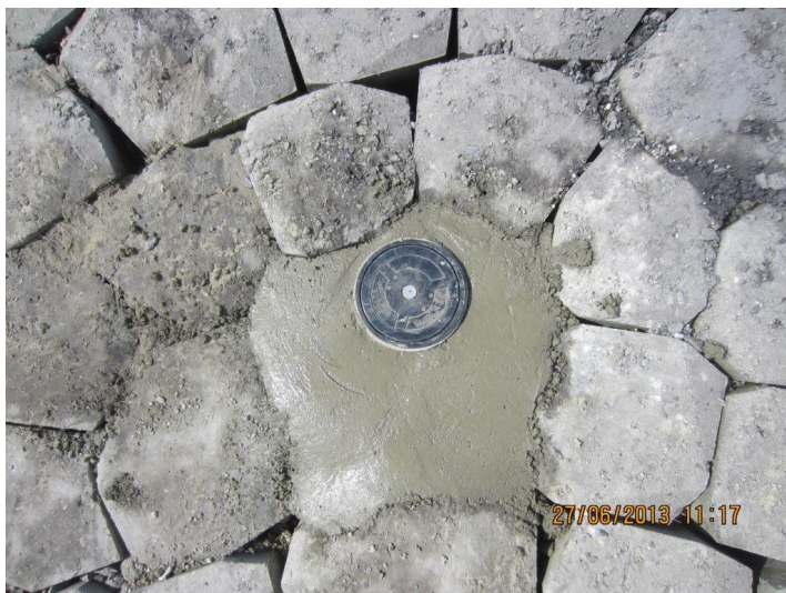
Figuur 4.4 Situatie voor DWP9 loc 2 na onderzoek: peilbuis geïnstalleerd, de verwijderde zuil is vervangen door ter plaatse gestort beton
