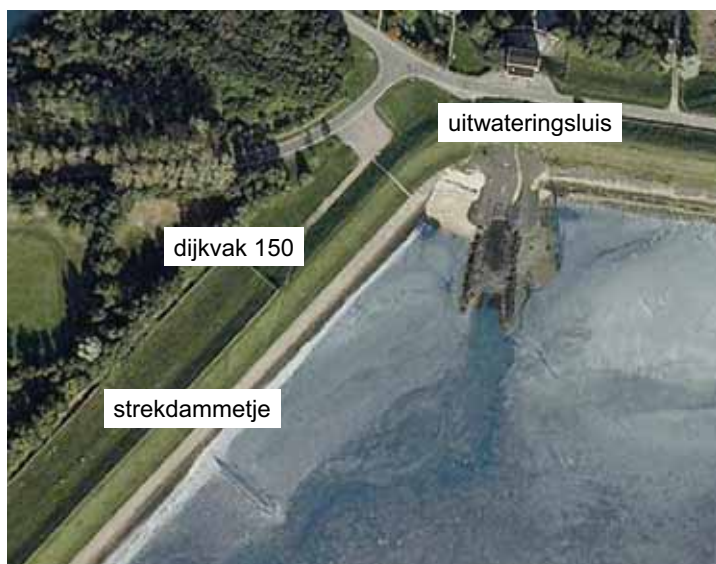
Figuur 1: Uitwateringsluis en strekdammetje (bron: Google Earth)
