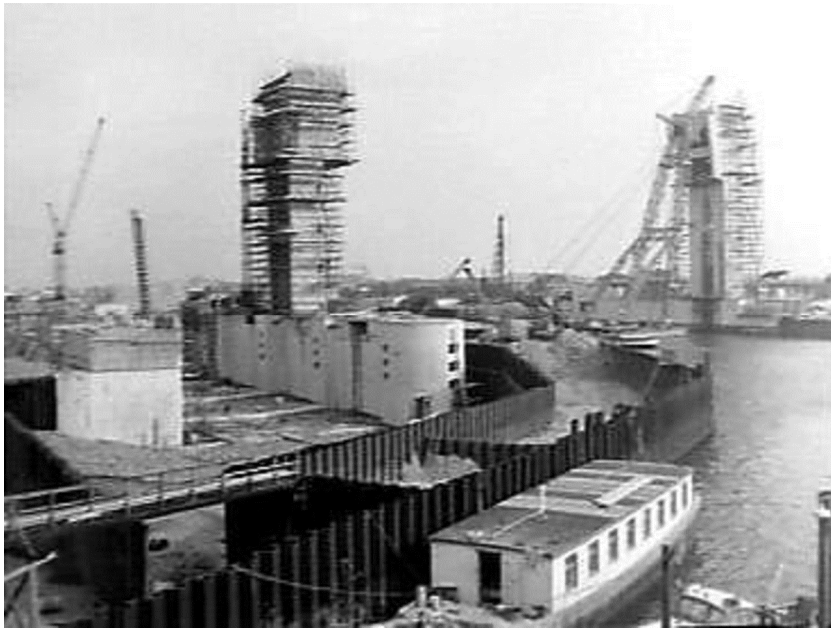
Zicht op de bouwkuip van de Hollandsche IJsselkering op de noordwestelijke oever. Een vergelijkbare dubbelwandige constructie is toegepast op de andere oever. (foto: RWS Beeldbank).
